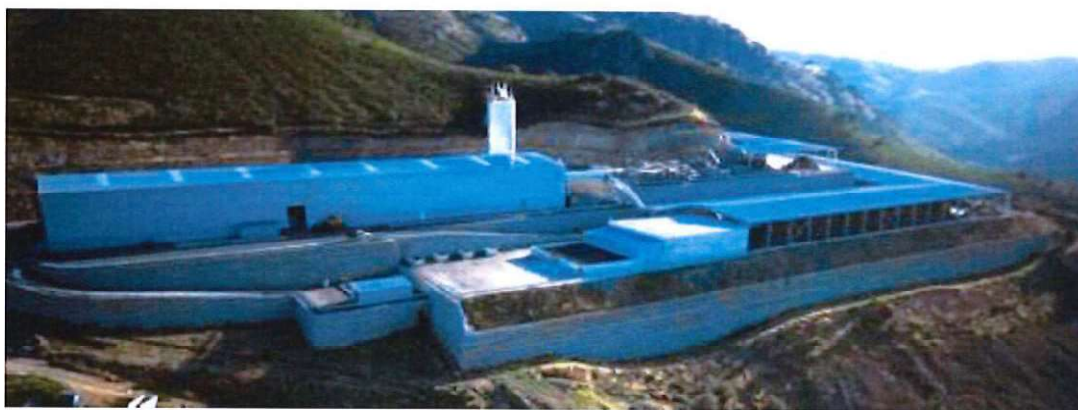
Figura 6 – Panorâmica Exterior da UTMB.
