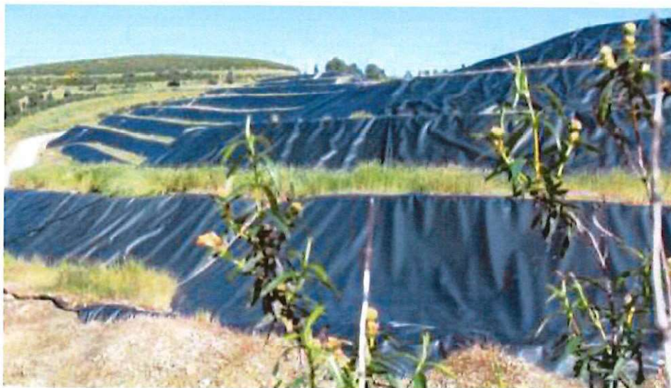
Figura 5 - Aterro Sanitário de Urjais – área selada.
