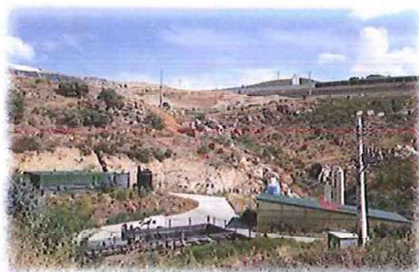
Figura 14 – Estação de Tratamento de Águas Lixiviantes
