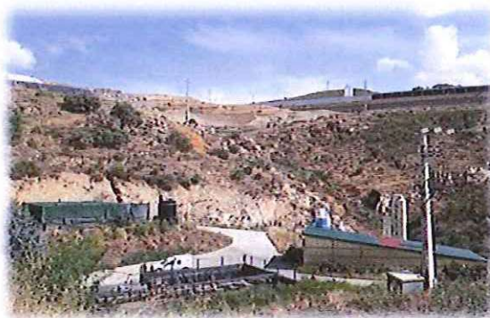
Figura 14 – Estação de Tratamento de Águas Lixiviantes
