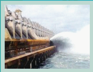
Fig. 9 - Hidroeléctrica do Torrão
