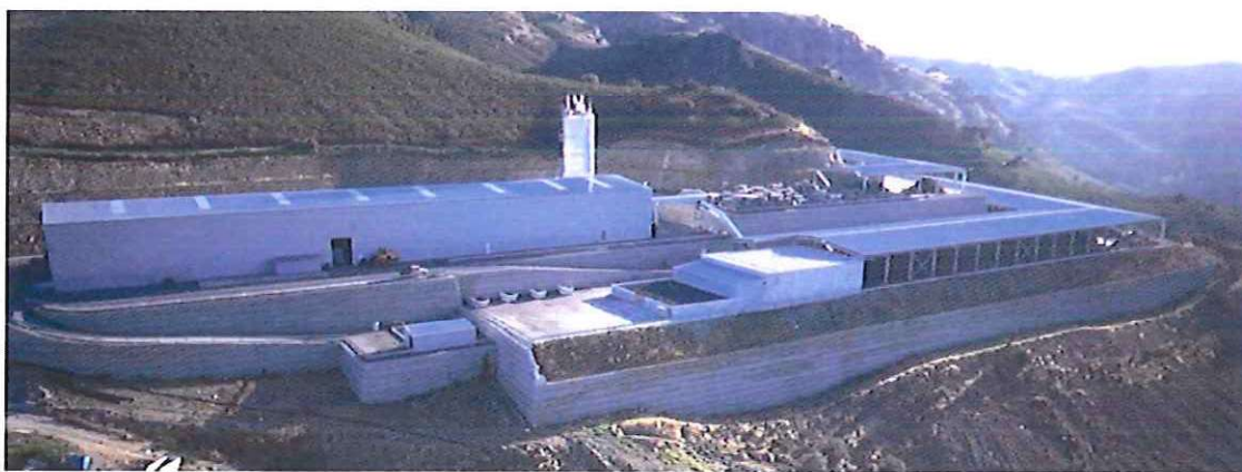
Figura 6 – Panorâmica Exterior da UTMB.
