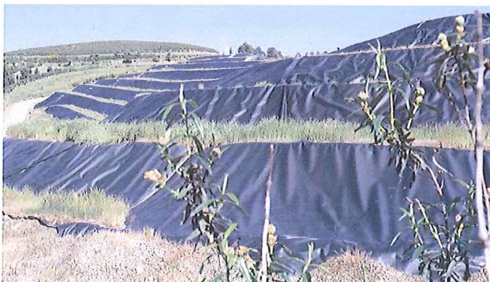
Figura 5 - Aterro Sanitário de Urjais – área selada.
