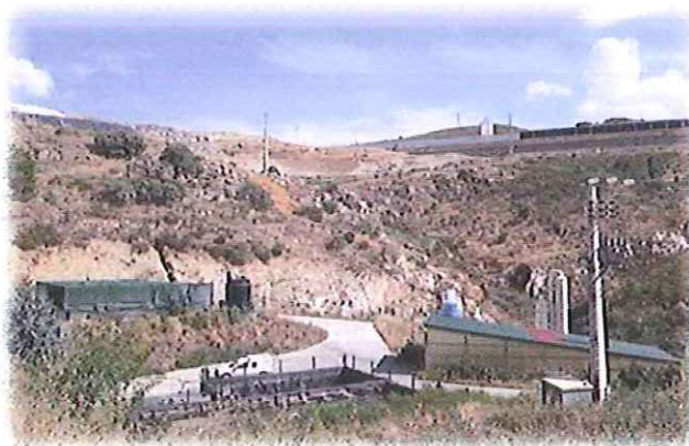
Figura 14 – Estação de Tratamento de Águas Lixiviantes.
