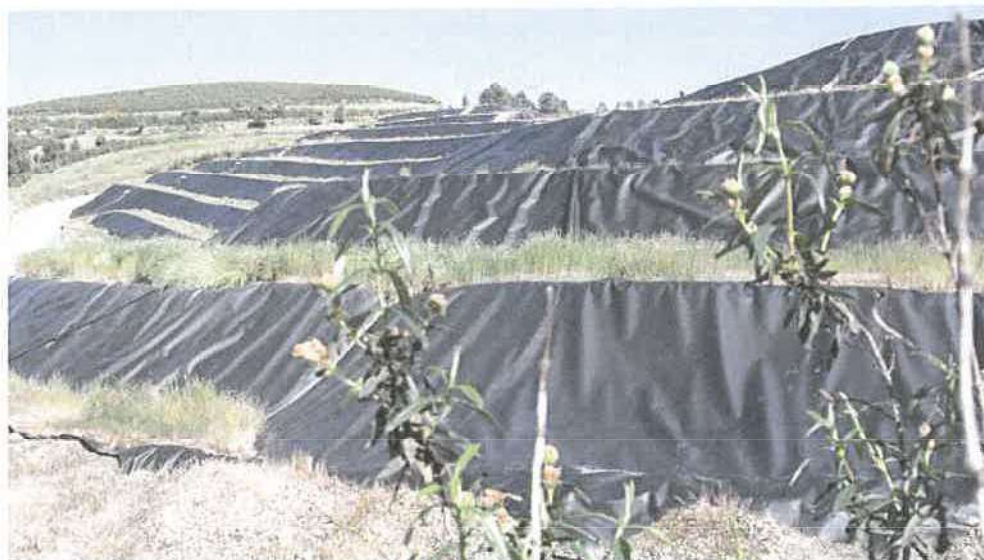
Figura 5 - Aterro Sanitário de Urjais – área selada.
