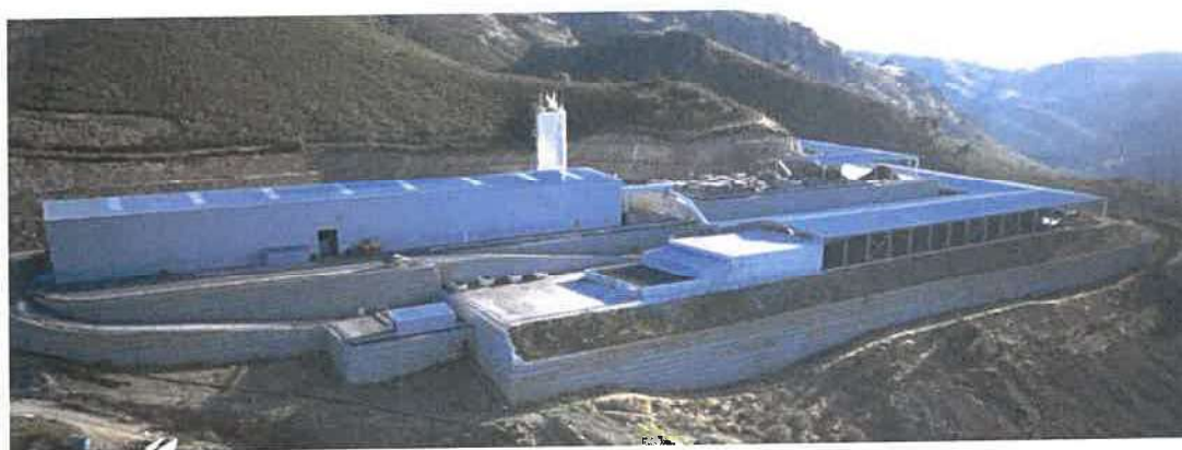
Figura 6 – Panorâmica Exterior da UTMB.
