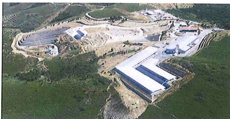
Fotografia 7: Parque Ambiental do Nordeste Transmontano
