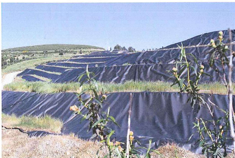
Fotografia 3 - Aterro Sanitário de Urjais – área selada
