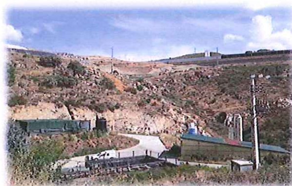
Figura 14 – Estação de Tratamento de Águas Lixiviantes.
