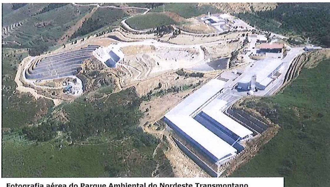
Fotografia aérea do Parque Ambiental do Nordeste Transmontano
