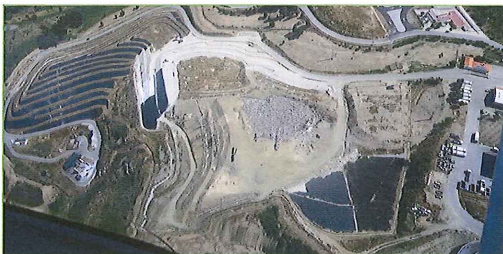
Fotografia 3 - Vista aérea do Aterro Sanitário de Urjaís (Parque Ambiental do Nordeste Transmontano)
